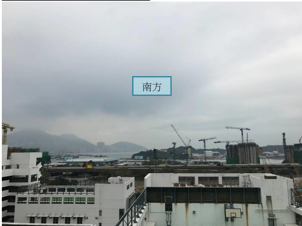
太陽能發電系統安裝位置南方照片
